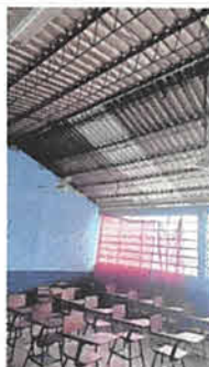
Foto 5: Sustitucion de laminas dañadas por lamina troquelada aluzinc 26
