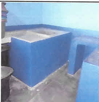
Foto 3: Fabricacion de pila de concreto 1.80x0.90x0.90 de alto incluye sistema de drenaje.
