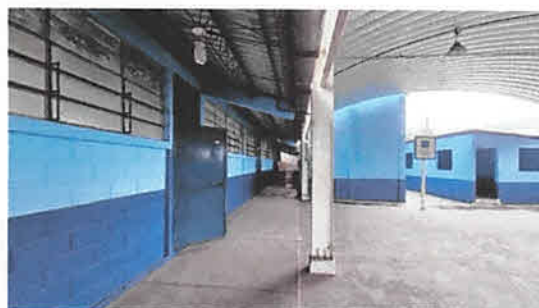
Foto 6: Resanado, lijado y pintado de puertas de metal.
