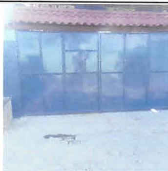
Foto 3: Resanado, lijado y pintado de porton principal.
