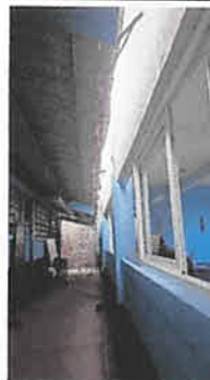
Foto 2: Sustitucion de canal y bajadas pluviales.
