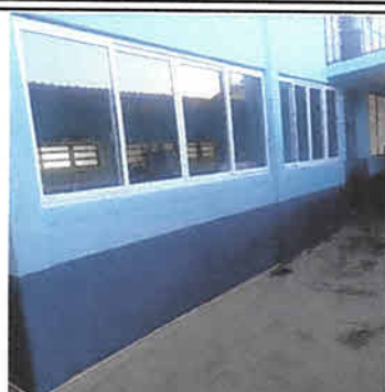
Foto 2: Fabricacion de ventaneria de PVC acabado blanco vidrio de 0.05 mm de grosor.
